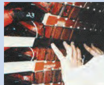
Instalação do Iris Power Stator Slot Coupler na ranhura de um estator.
