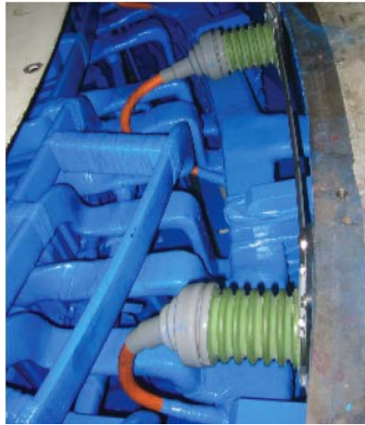
水力発電機内に取り付けた PDAカプラー
