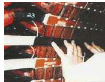
Instalación de Iris Power SSC en una ranura de estator
